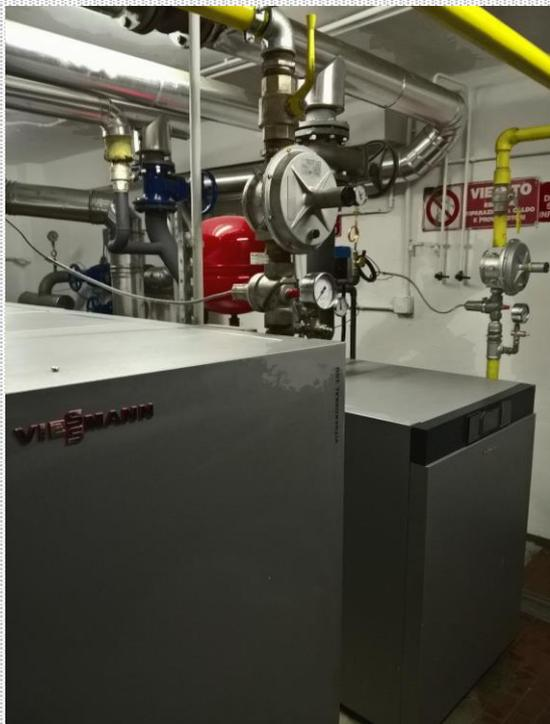
Riqualificazione impianto mediante 2 nuove caldaie a condensazione da 400 + 140 kW (caldaia piccola per produzione estiva ACS)
