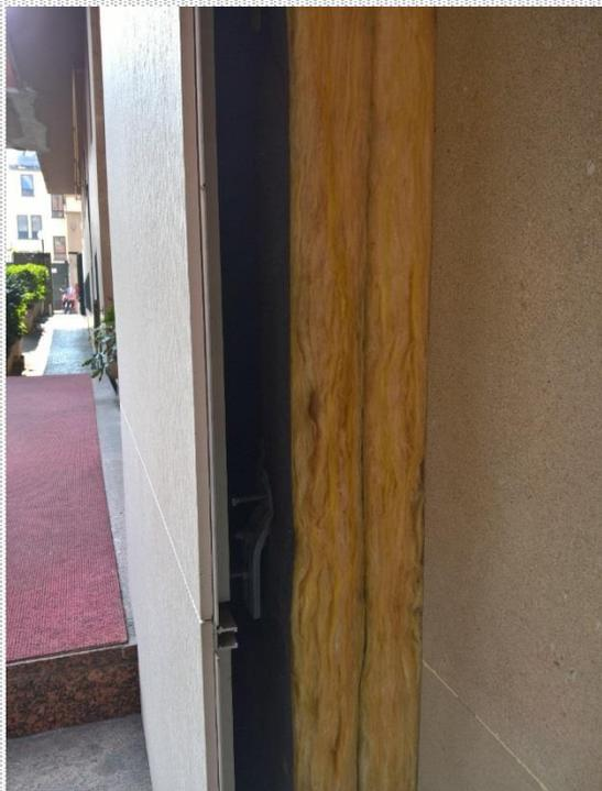
Riqualificazione mediante isolamento a cappotto del 76% delle strutture opache disperdenti (strutture verticale e copertura)
